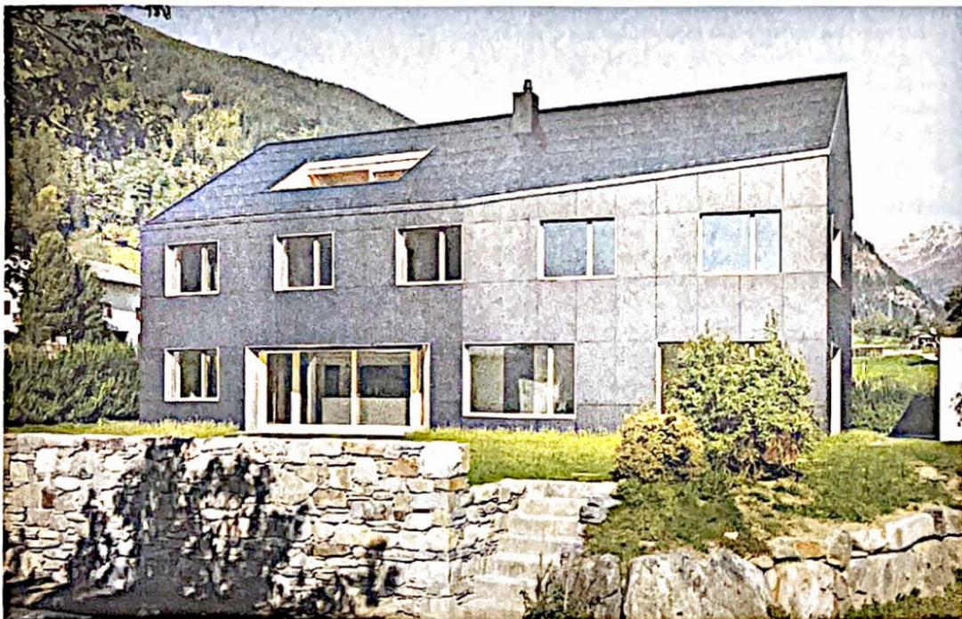
Das Winter-Plusenergiehaus Sol'CH in Poschiavo (GR) ist ein prämiertes Paradebeispiel der integrierten Photovoltaik. Die ganze Gebäudehülle, also inklusive Nordfassade, besteht aus PV-Modulen.
