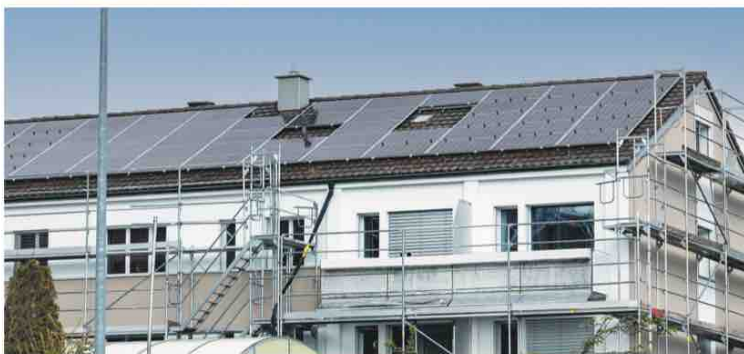
Optimal nutzt man die Energie einer Photovoltaikanlage durch ein zentrales Energiemanagement.
